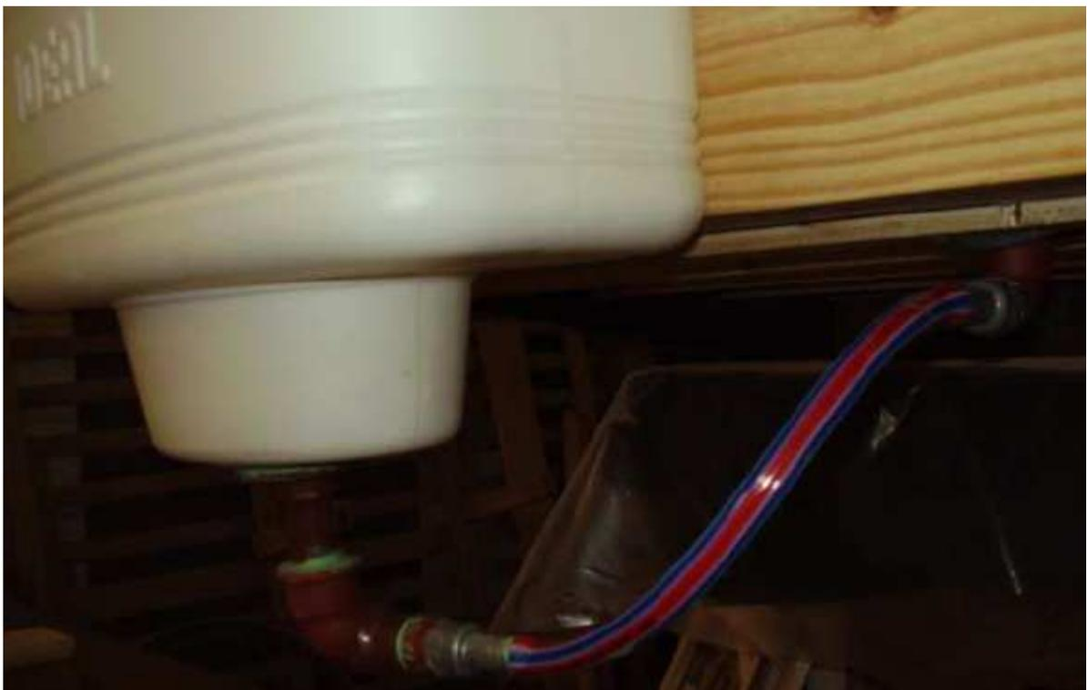
En la foto anterior se observa dicho recipiente de control instalado en una de las cabeceras del colector solar.
