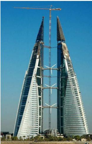
*Edificio alimentado eléctricamente con EE*
